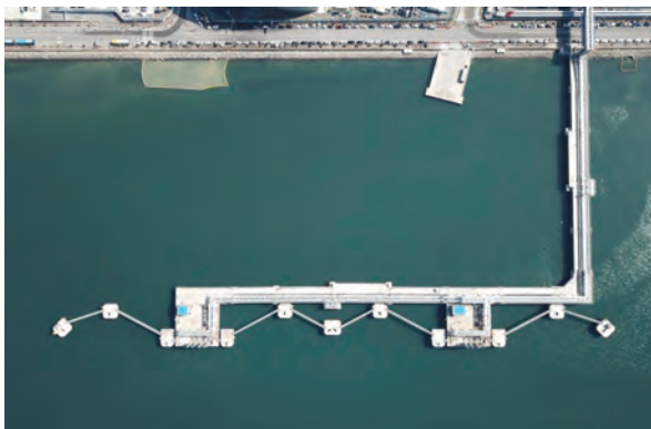
LG화학 제품부두 축조공사(2020, Jetty 시설)
